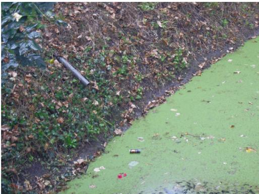
Weit über die Böschung ragende Drainageausläufe können bei der Unterhaltung beschädigt werden. Eine deutlich sichtbare Kennzeichnung auf der Böschungsoberkante sowie Kürzung des Auslaufes sind per Satzung geregelt.
